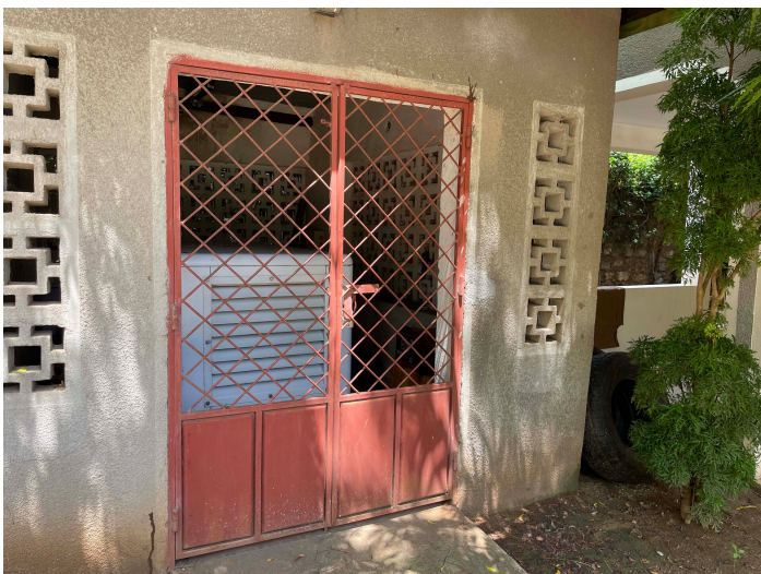
Der Generator - gleich neben den Büros
