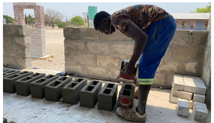
Lernender beim Fertigen von Bausteinen
